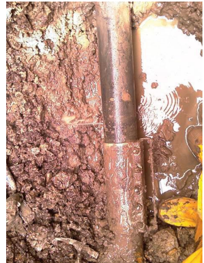
図 7. ゾーンスキャンによって発見された漏水
